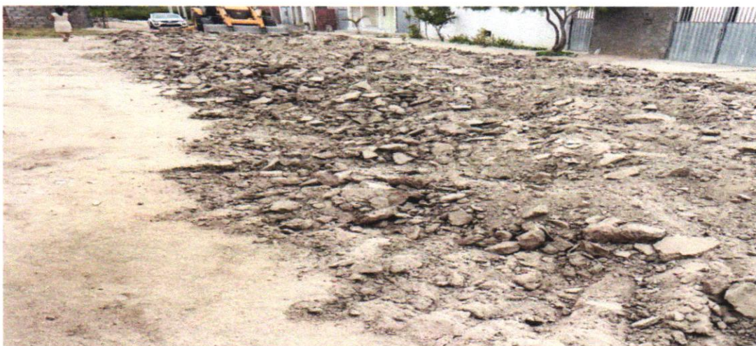
FOTO 01 REGULARIZAÇÃO E COMPACTAÇÃO
