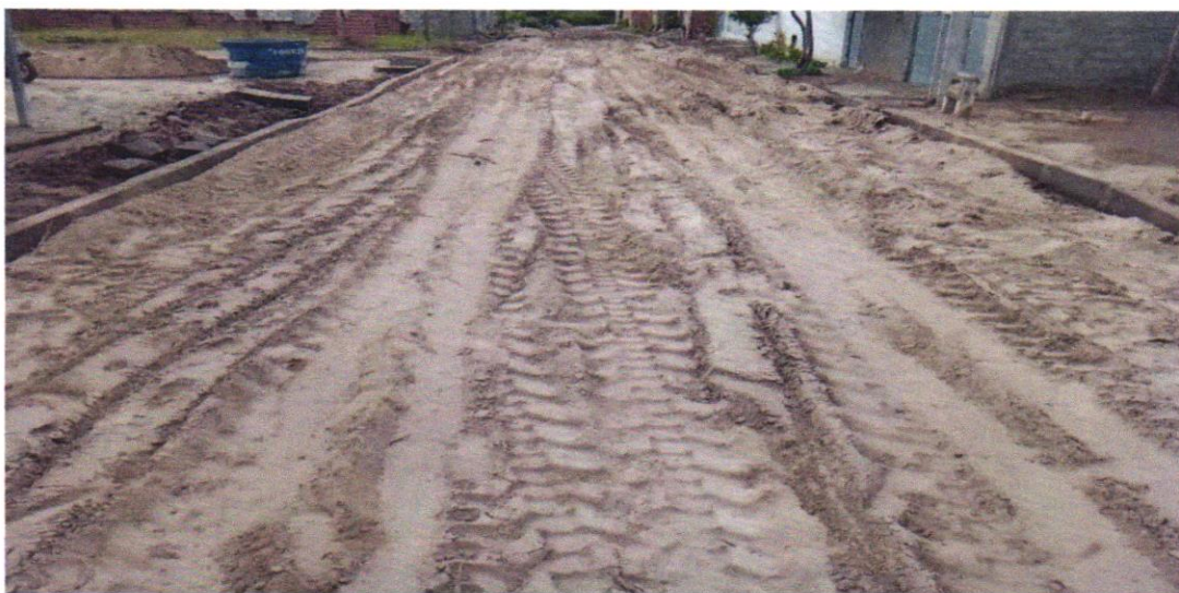
FOTO 02 REGULARIZAÇÃO E COMPACTAÇÃO
