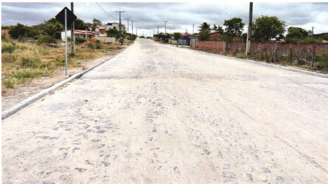
(FOTO 05) EXECUÇÃO DE PAVIMENTAÇÃO E MEIO FIO
