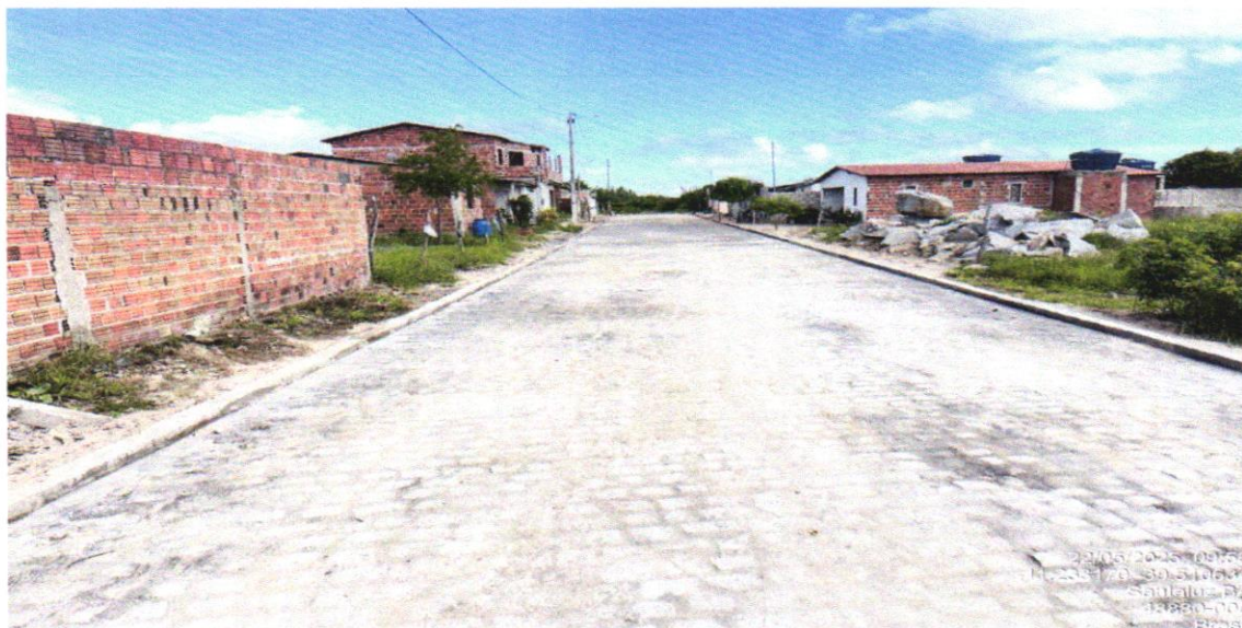
(FOTO 07) EXECUÇÃO DE PAVIMENTAÇÃO E MEIO FIO
