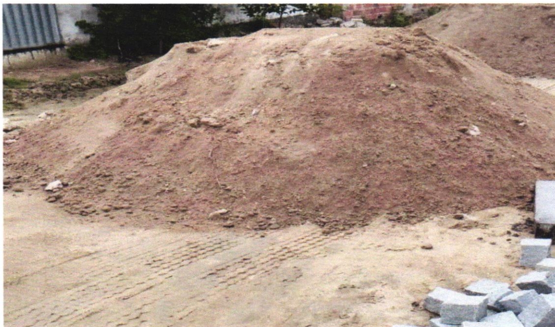
(FOTO 03) AREIA PARA COMPACTAÇÃO DO LEITO
