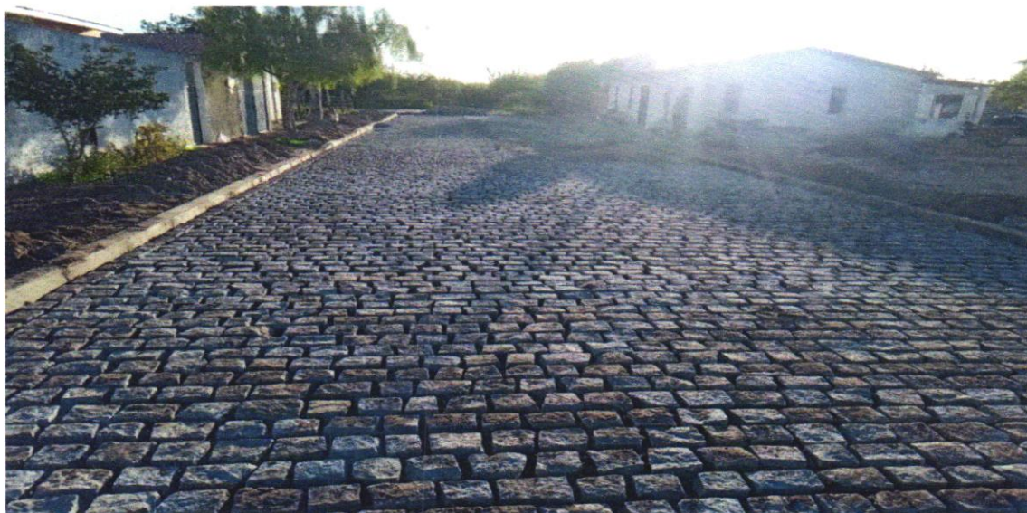
(FOTO 08) EXECUÇÃO DE PAVIMENTAÇÃO E MEIO FIO
