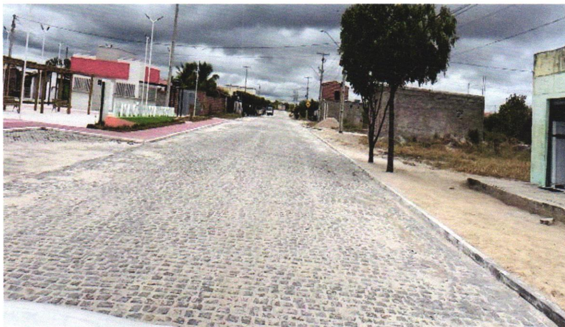
(FOTO 06) EXECUÇÃO DE PAVIMENTAÇÃO E MEIO FIO
