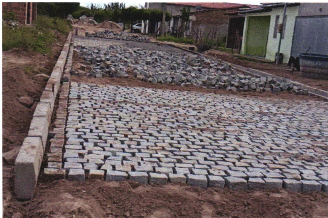
(FOTO 04) EXECUÇÃO DE PAVIMENTAÇÃO E MEIO FIO
